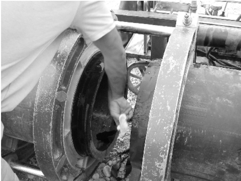
شکل (۱): تمیز کردن لبه های لوله با الکل
