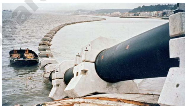
شکل (8)-نمونه اجرای پروژه دریائی لوله پلی اتیلن
